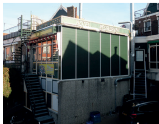
Gevelbekleding van Keralit
